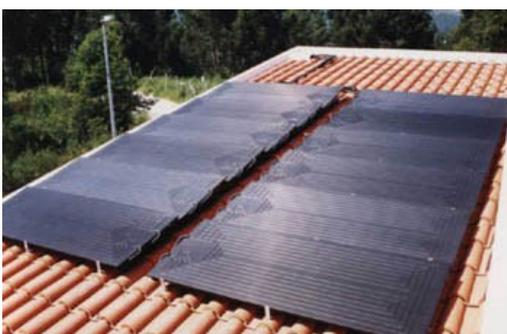
La energía térmica se obtiene directamente al exponer cualquier objeto a los rayos solares. Mediante **paneles solares** podemos, por ejemplo, calentar el agua de nuestras casas.
